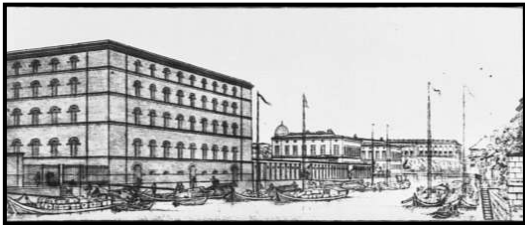
Ansicht des Neuen Packhofs von Norden aus:
