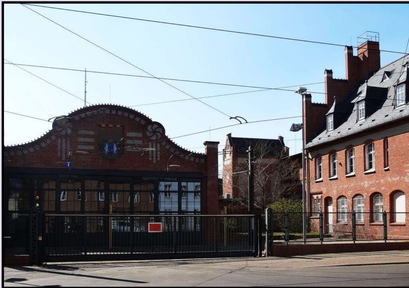
Betriebshof der städtischen Straßenbahnen Köpenick (2015)
