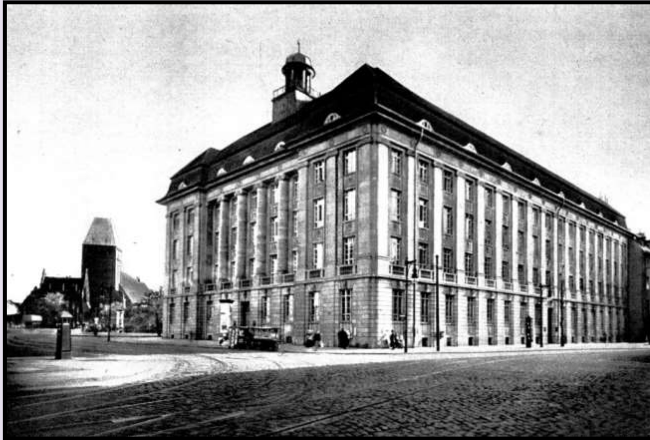
Verwaltungsgebäude der Gaswerke, im Hintergrund Märkisches Museum
