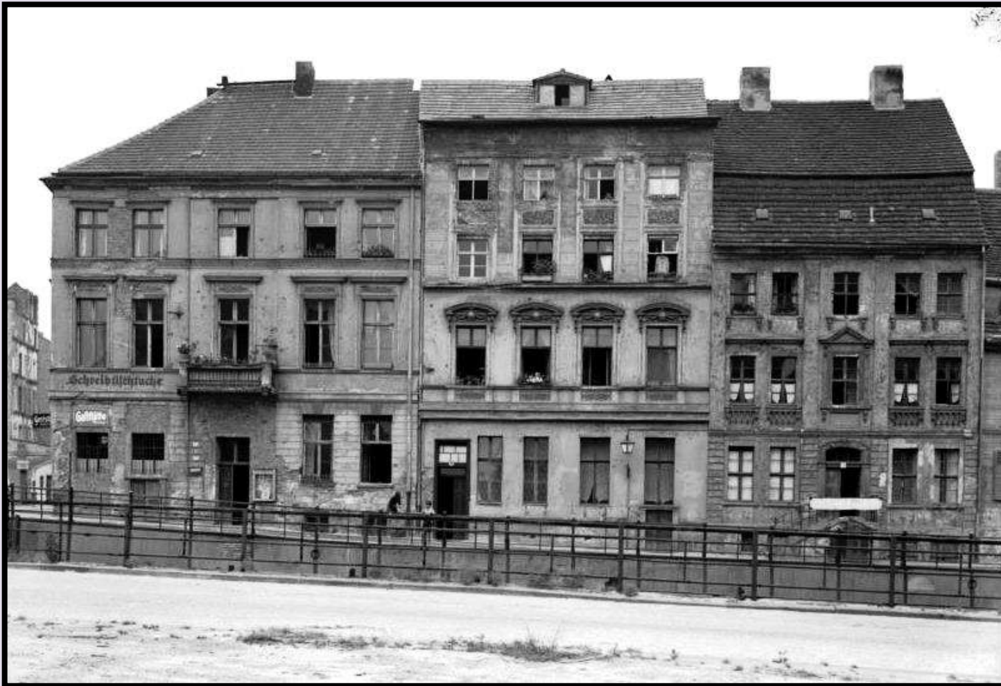
Die 1968/1969 abgerissenen Häuser Friedrichsgracht 15-17 im Jahr 1952
