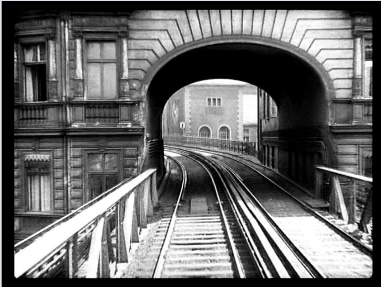
U-Bahn-Durchbruch Dennewitzstraße (Tiergarten) (1927)
