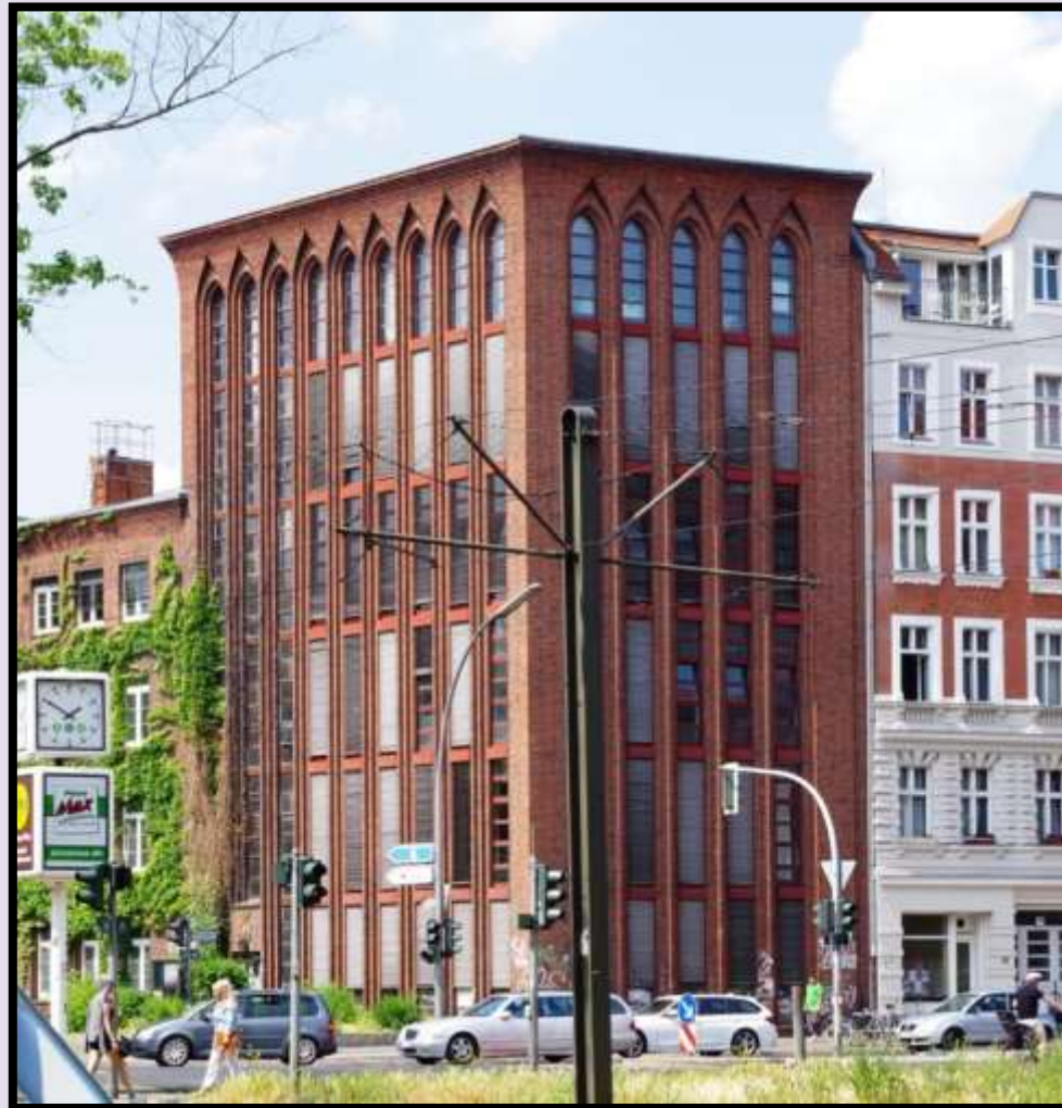
Abspannwerk Christiania (Wedding/Gesundbrunnen) (2018)
