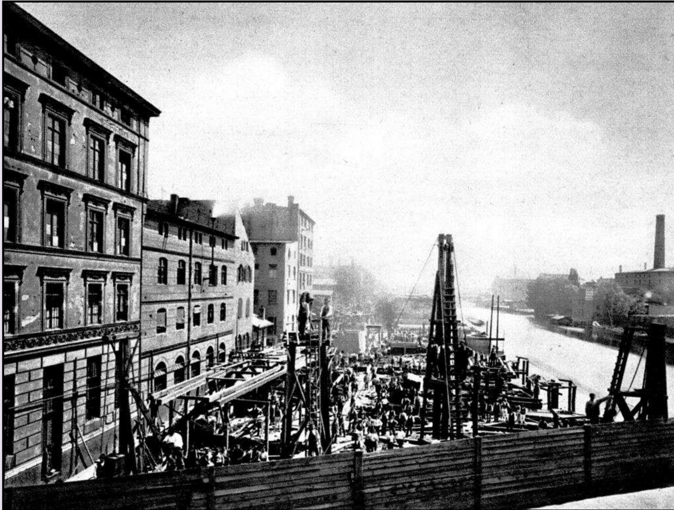
Bau des Stadtbahnhofs Jannowitzbrücke (1880)
