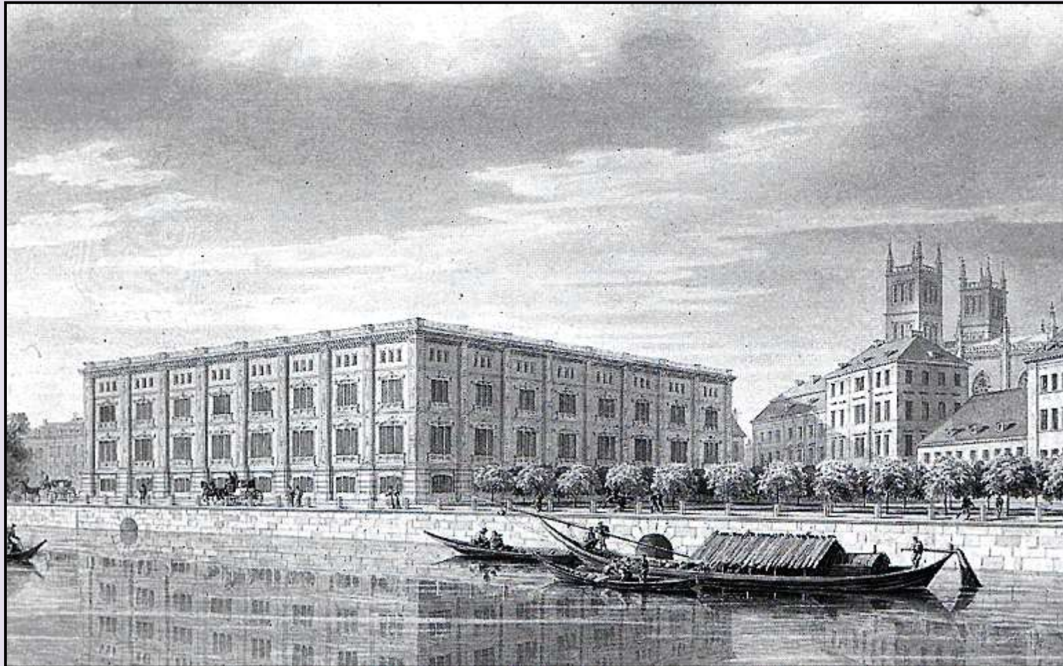
Bauakademie, rechts hinten Friedrichswerdersche Kirche
