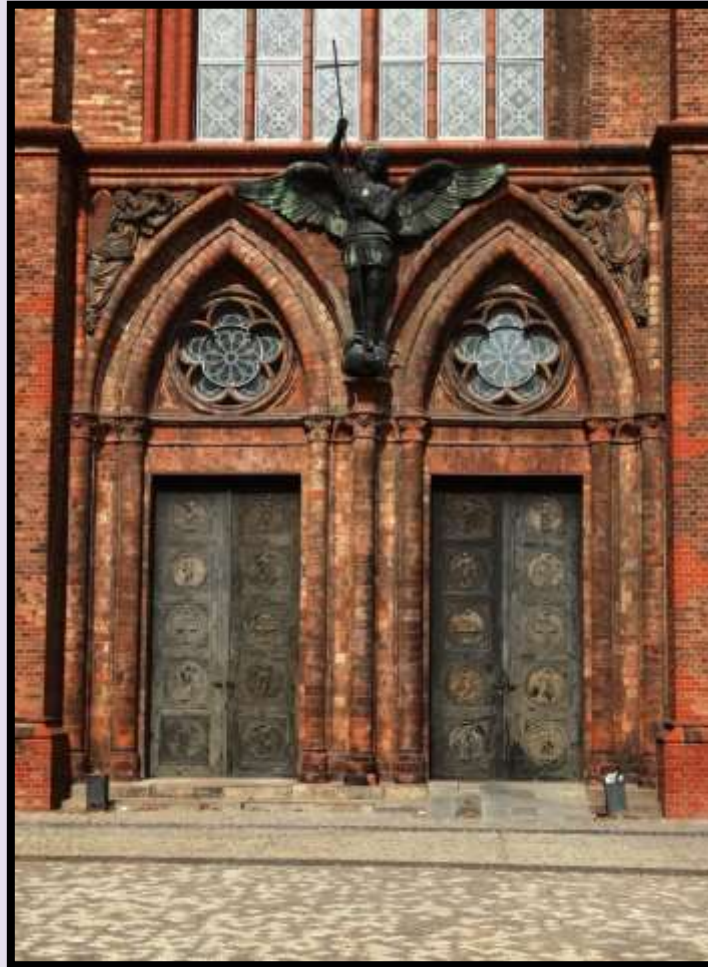
Friedrichswerdersche Kirche, Portal (2018)
