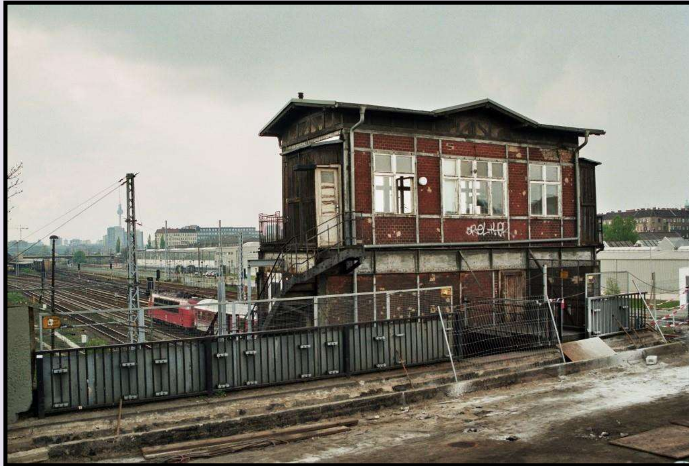
Reiterstellwerk an der Modersohnbrücke (Friedrichshain) (1999)
