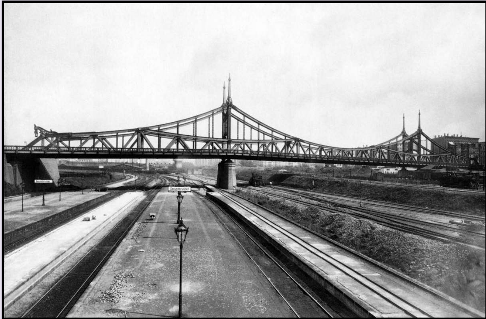
Swinemünder Brücke (Wedding/Gesundbrunnen)
