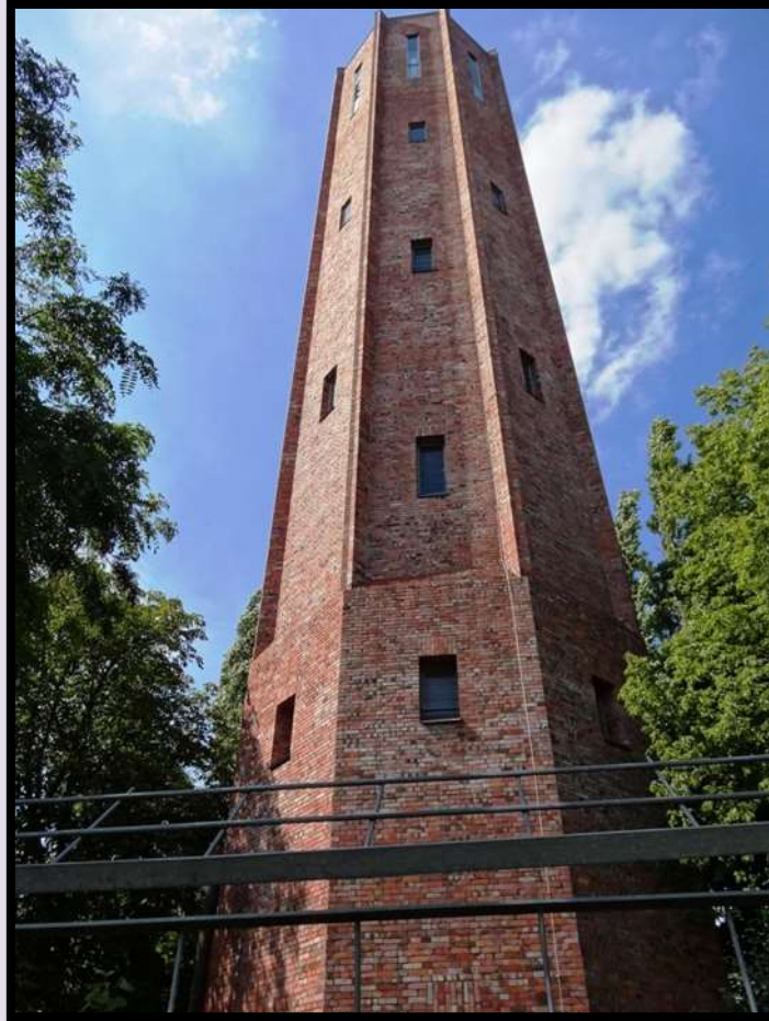
Wasserturm des ehemaligen Gaswerks Lichtenberg, Rummelsburg (2016)
