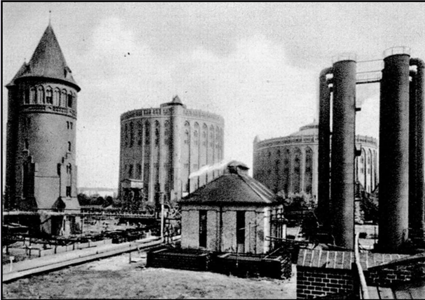
Gaswerk Tegel (um 1930)
