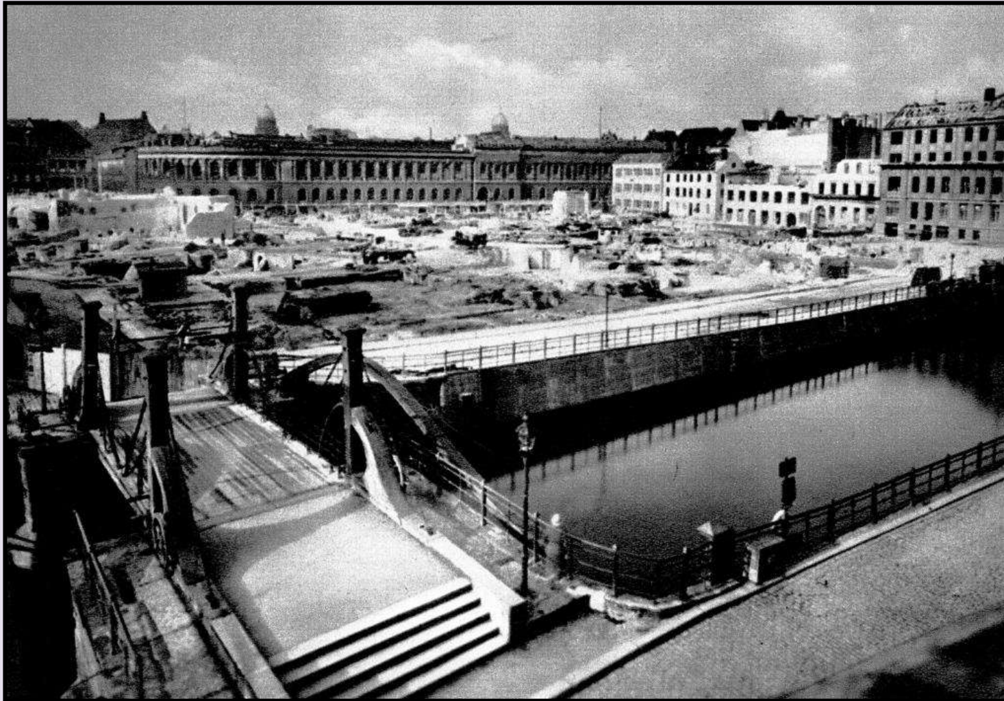
Bauplatz der neuen Reichsbank, Jungfernbrücke
