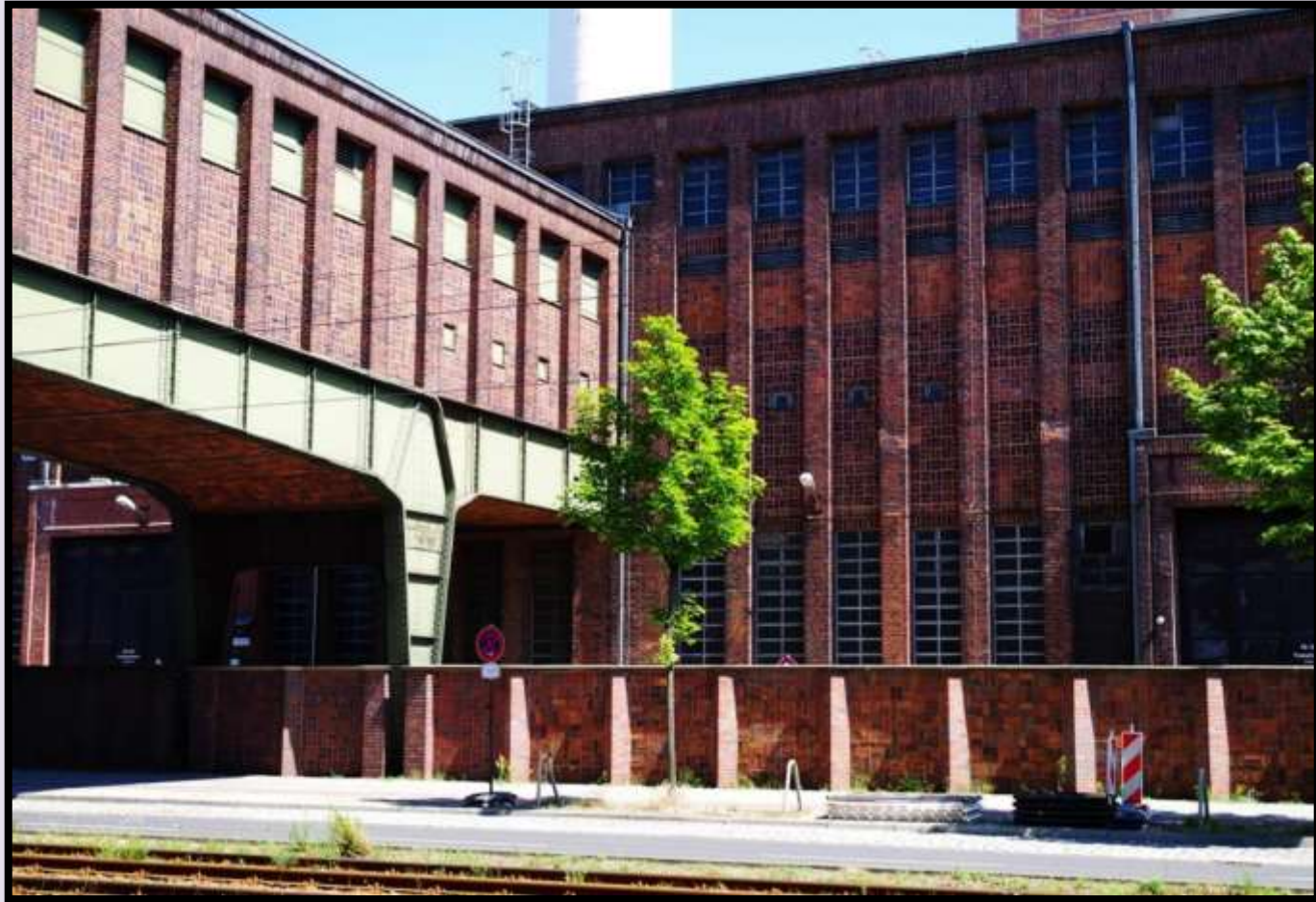
Kraftwerk Klingenberg (Lichtenberg) (2018)
