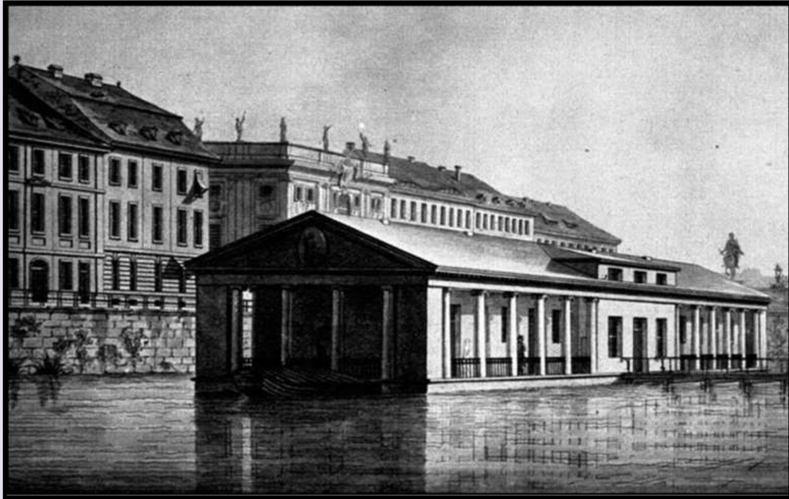
Badekahn an der Kurfürstenbrücke (Rathausbrücke) (um 1830)
